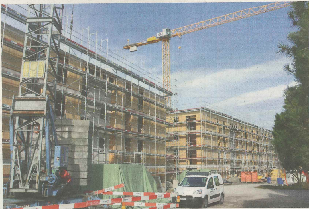
Überbauung Wohlermatte in Anglikon: Von über 100 Wohnungen sind 35 fertig, 33 davon sind vermietet.
